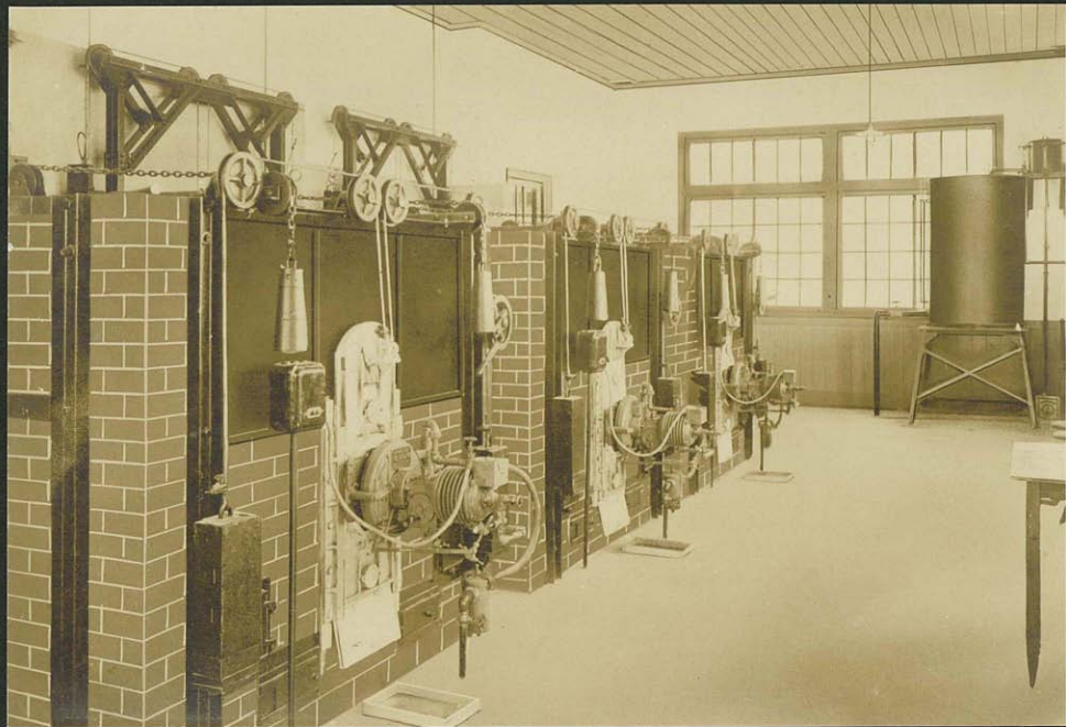
特許三機式重油火葬爐背面
