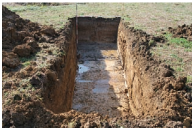
No. 2 トレンチ
