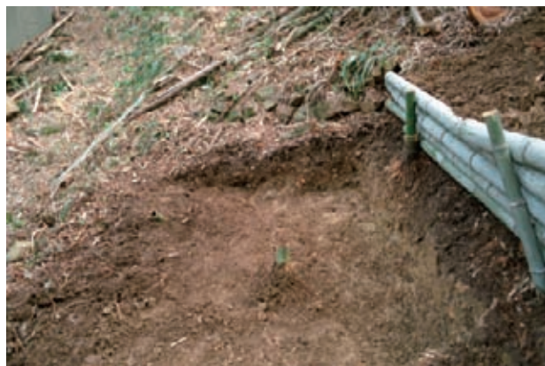
No. 5 トレンチ
