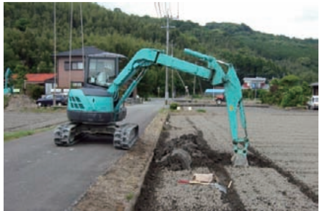
白石平野地区（1） 作業状況
