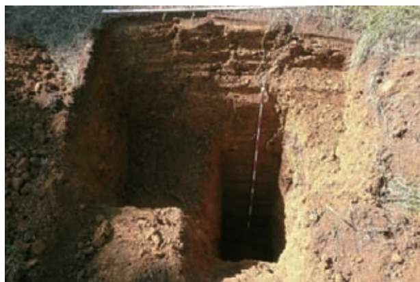
No. 1 トレンチ
