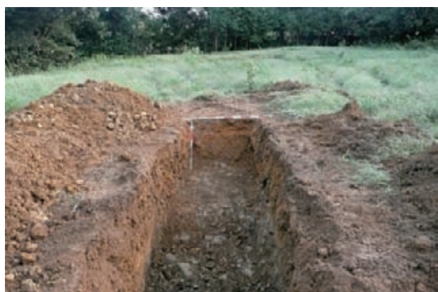
No. 6 トレンチ
