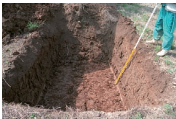
No.50 トレンチ
