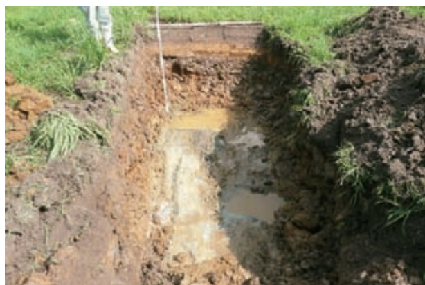
No. 1 トレンチ
