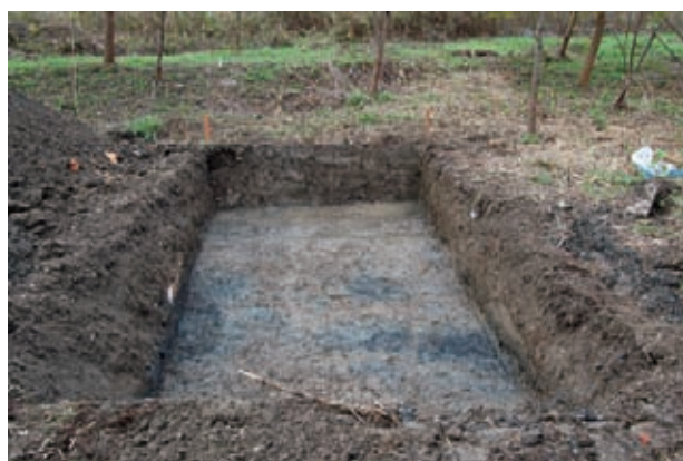
No. 4 トレンチ
