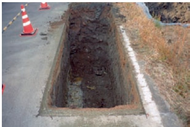
No. 1 トレンチ
