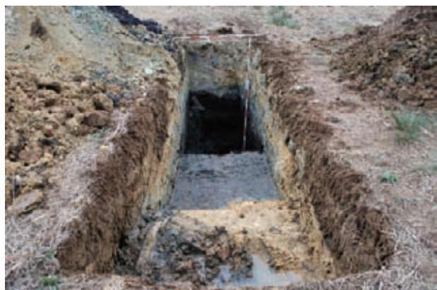
No. 1 トレンチ
