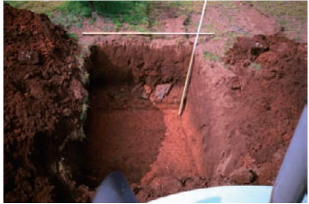
No. 2 トレンチ
