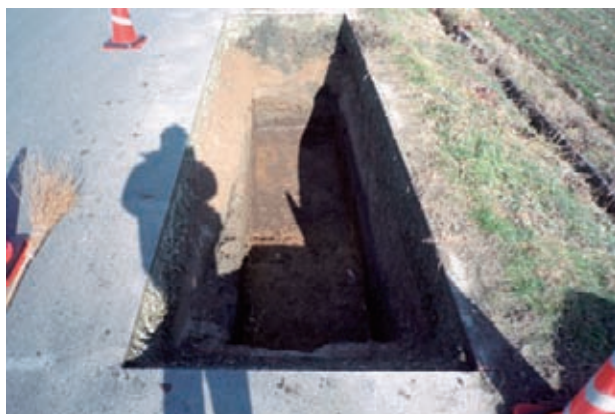
No. 4 トレンチ
