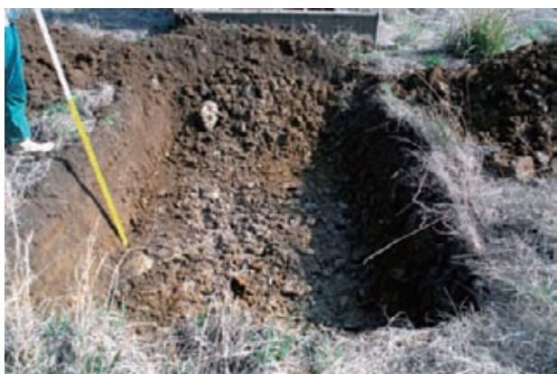
No.29 トレンチ
