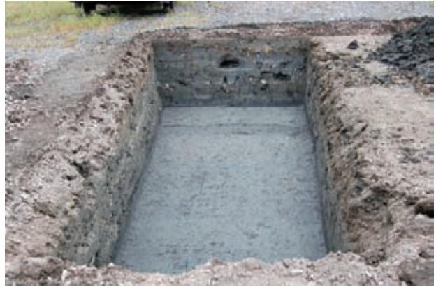
No. 1 トレンチ
