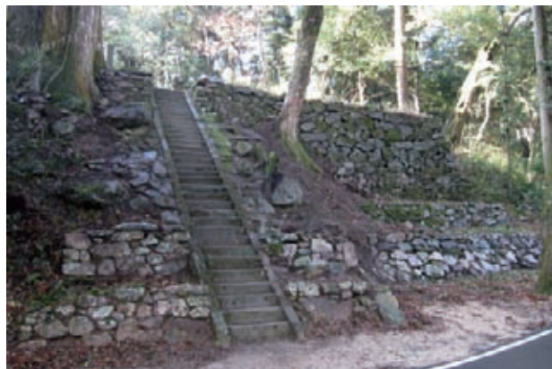
調査地前面の石垣
