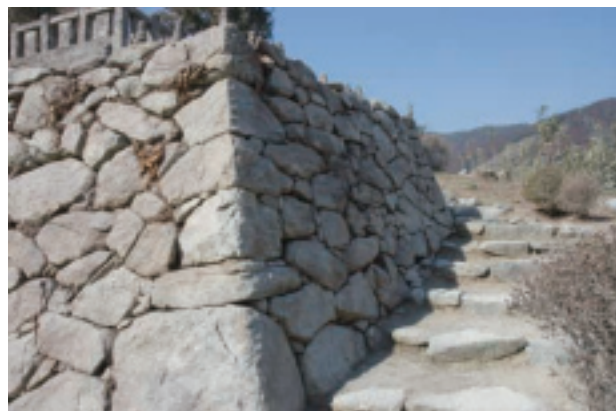
石垣北面（東から）
