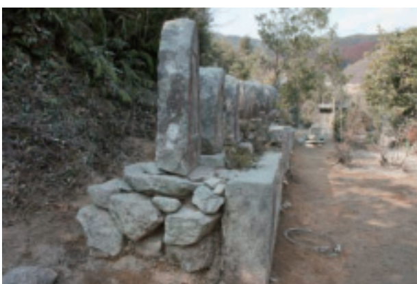
SX9002 ～ SX9016 (北東から)
