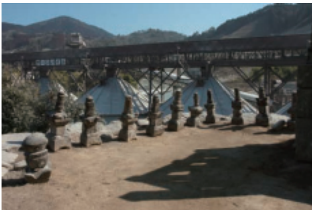
SX9051 ～ SX9058 (南西から)
