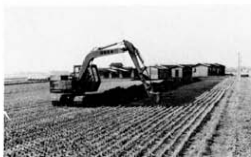
Fig 2 掘削機による表土剥ぎ（尾崎土生遺跡11区）
